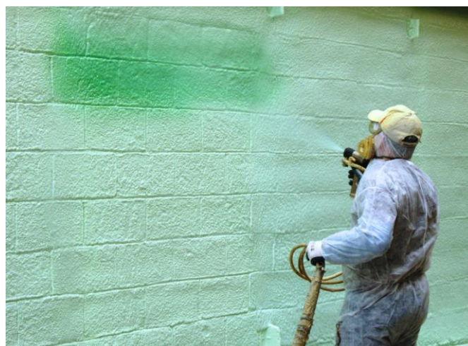
Figura 1.1: Proyección de Elastospray 1623/10/DAU:IsoPMDI 92140.
