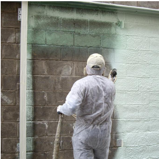
Figura 6.14: Aplicación de la capa de imprimación.
